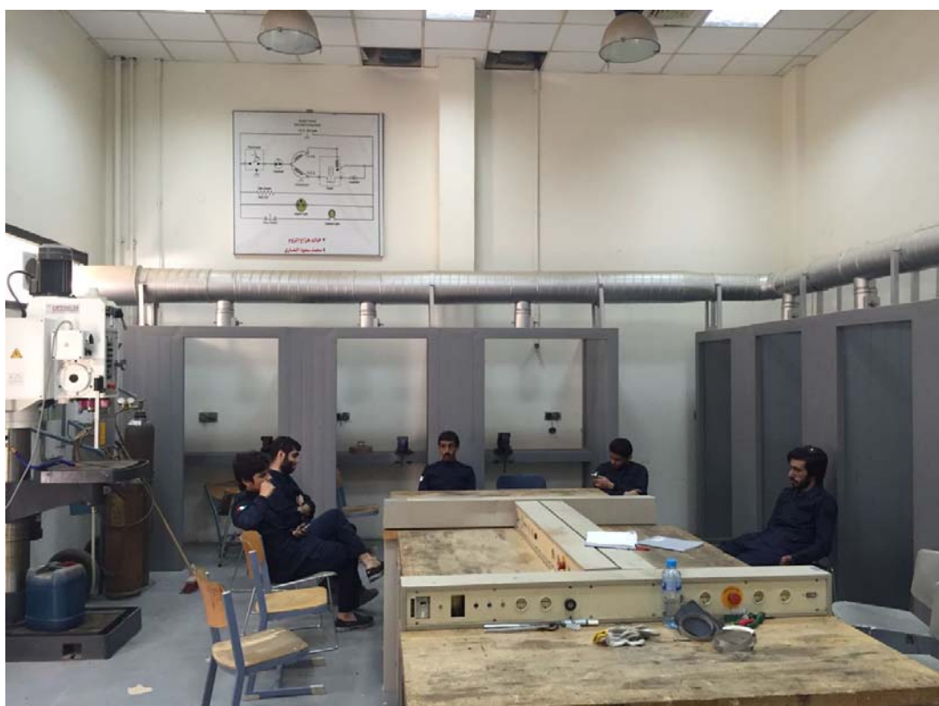
شكل (31): يوضح الفراغ المناسب وتناسق الاجهزة بورشة التمديدات الكهربائية
