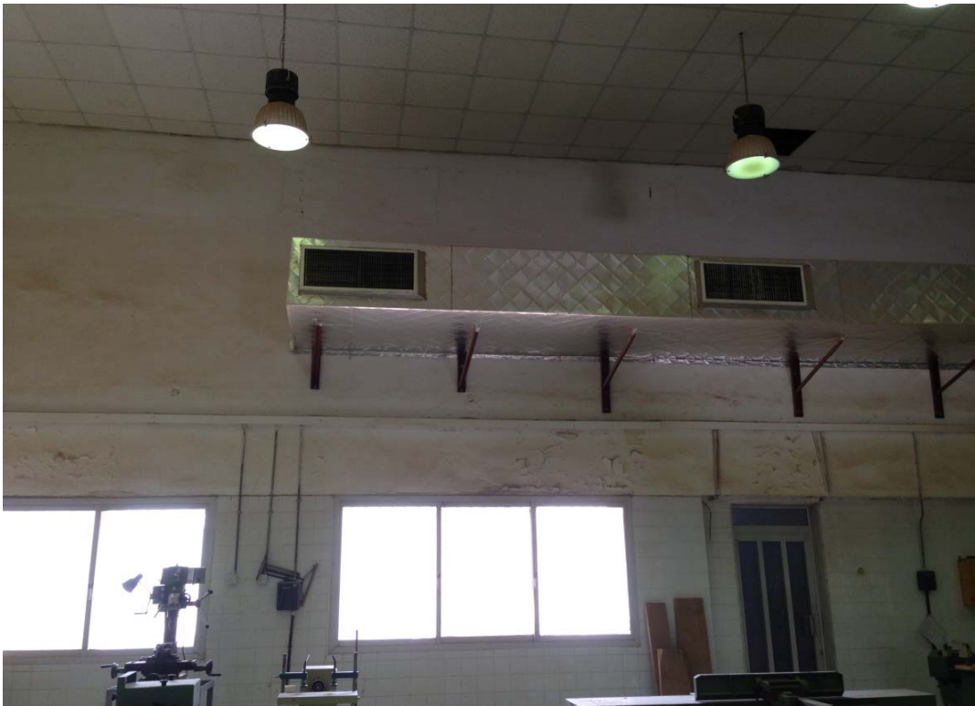
شكل (5): صورة توضح الاضاءة والتكييف المركزي بالورشة والشبابيك
