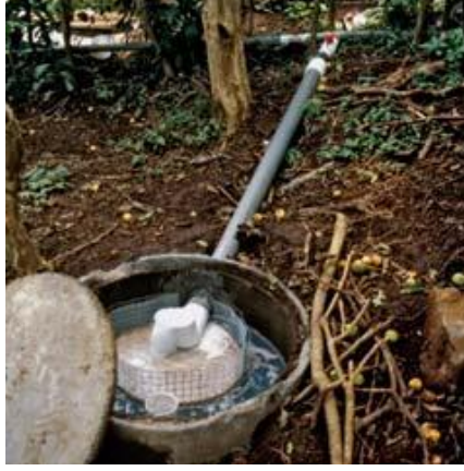
شكل (4) خزان الترسيب يحتوي على شبكة فولاذية لتسهيل عملية التنظيف
